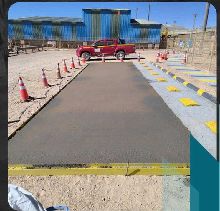
**FABRICACIÓN DE FUNDACIÓN DE HORMIGÓN, ACABADO ANTIÁCIDO EN PLANTA DE CLORURO**
